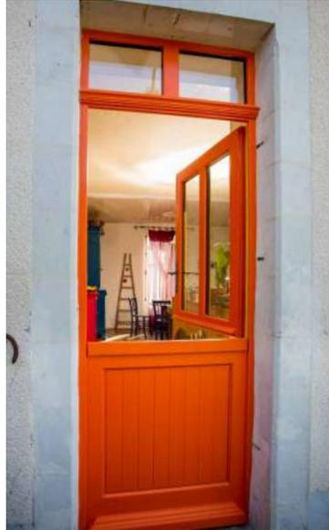
bénéficiant d'une ouverture indépendante de la partie haute par un bouton au centre de la porte. La manœuvre de la poignée verrouille automatiquement les deux vantaux et permet l'ouverture de la partie haute et basse simultanément.
