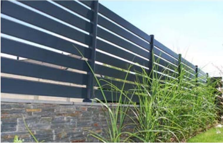
Clôture réalisée avec des profils de 100x20mm disposés horizontalement sur des potelets de 50x60mm.
