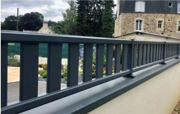
Barreaudage avec des profils de 100x20mm disposés verticalement espacés.
