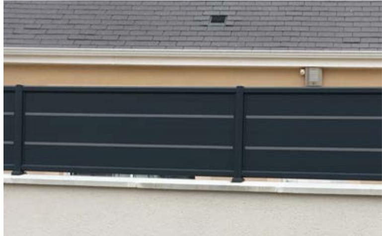
Lames de 100x20mm horizontales et serrées, agrémentées de deux listels façon inox.
