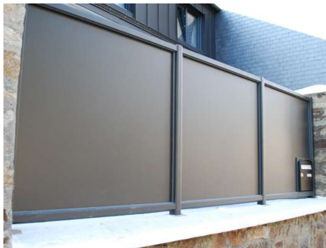
Clôture tôle laquée
