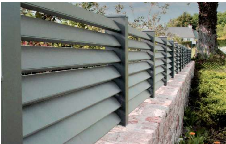
Clôture en aluminium réalisée avec des planches de section 70x20mm déversées à 60° disposées horizontalement. Poteaux de 70x70mm.
