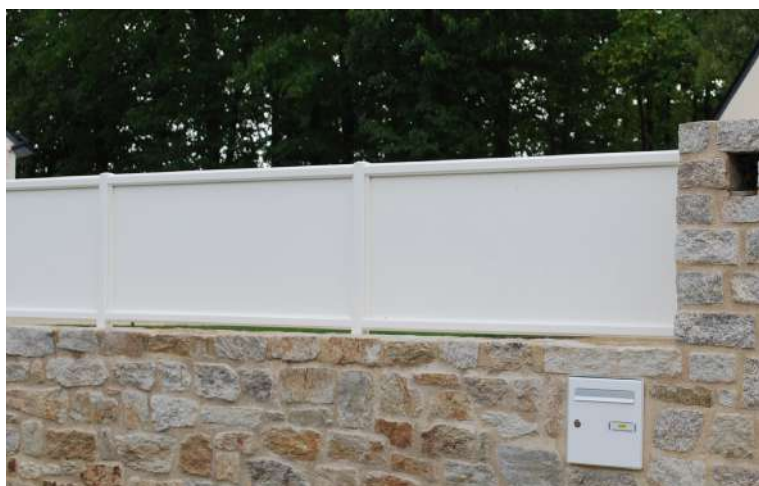
Tôle laquée deux faces fixée en pourtour par des parcloles.
